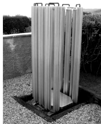
Рис. 2 Випарник ТН Octorus
